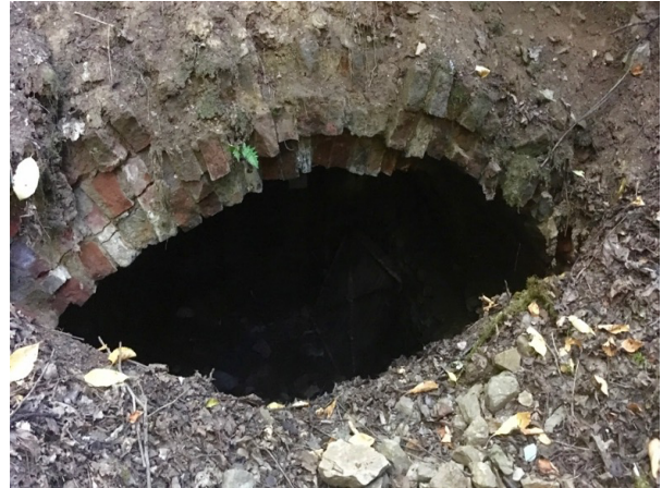
Abb. 3: Stollenmund im Sohlenbereich des stillgelegten Kalktagebaus
